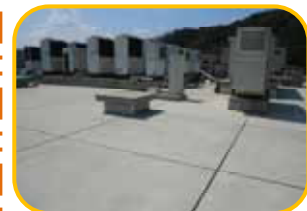
防水工事完了
